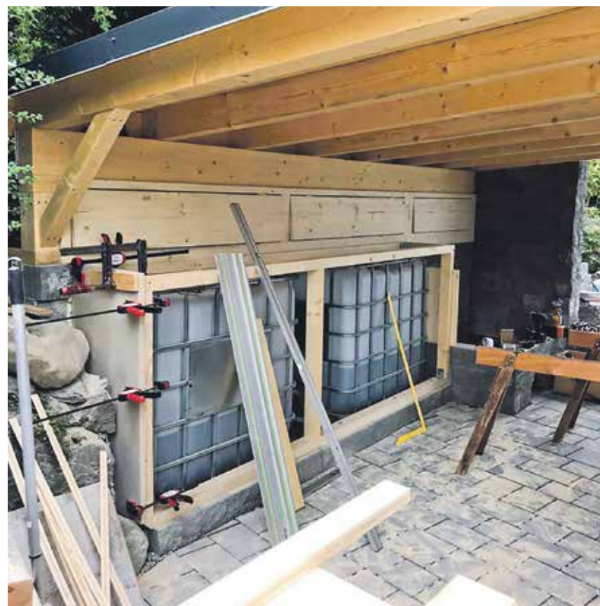
Zukunftsweisendes Projekt «Marke Eigenbau»: Die zwei Regenwassertanks bewässern den Garten und füllen den Teich. Bild: zVg
